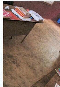
Foto 6: Mantenimiento de piso en aulas
