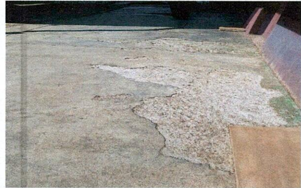
Foto 2: Mantenimiento piso corredor
