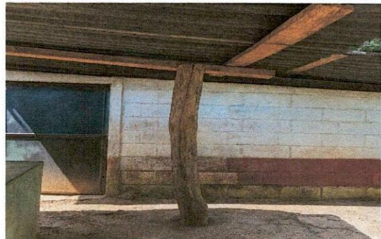
Foto 4: Mejorameinto de techo en área de cocina
