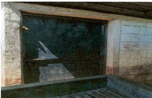
Foto 5: Reparación y Mejorameinto de paredes de cocina
