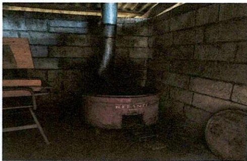
Foto 3: Reparacion y mejoramiento piso cocina
